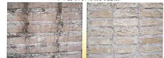
●施工していない外壁 ●施工した外壁
