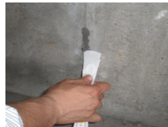
CSパテすり込み
